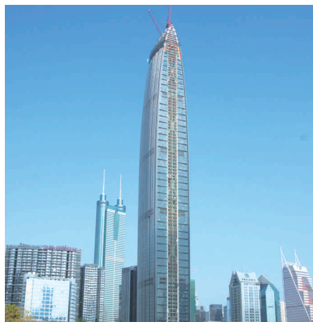
深圳京基大厦施工现场 Kingkey Financial Center Construction Site,Shenzhen
