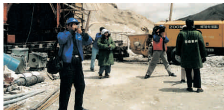
青藏铁路施工现场 Qingzang Railway Construction Site
