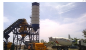
缅甸：港建项目
