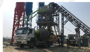
孟加拉：港口办公区扩建项目
