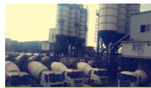
安哥拉：钢结构工程建设项目
