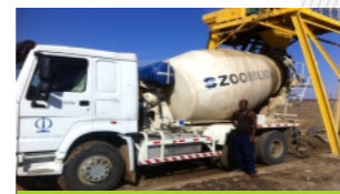
埃塞俄比亚：铁路项目
