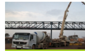
塞内加尔：水泥厂建设项目
