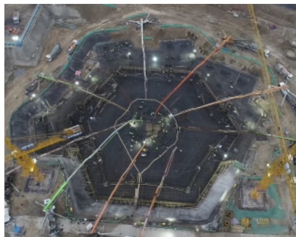
丝路明珠塔项目建设
