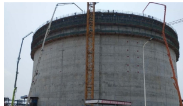
中科石化建设施工
