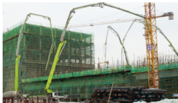
安徽亳州粮仓项目浇筑
