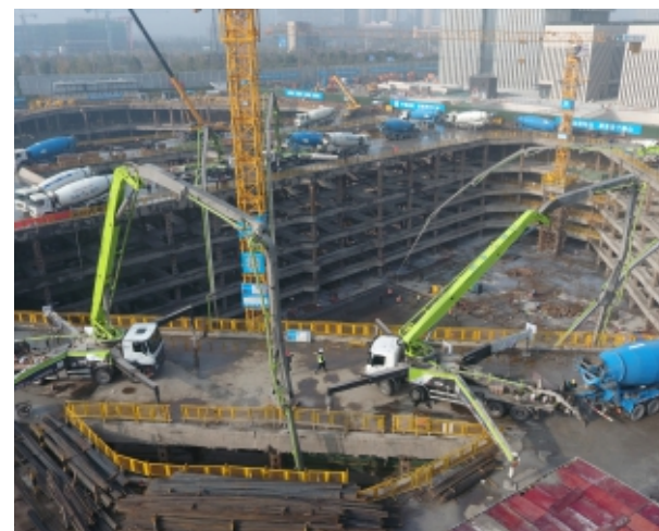
金融城项目建设施工
