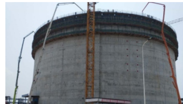
中科石化建设施工
