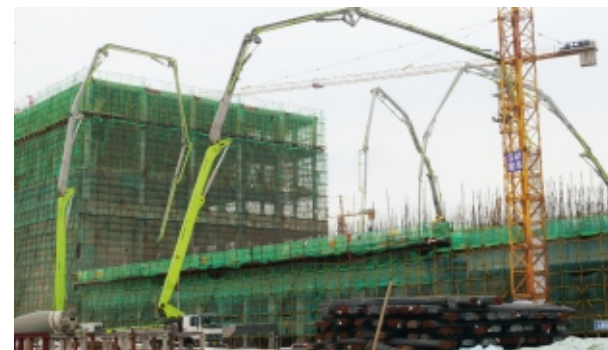
安徽亳州粮仓项目浇筑
