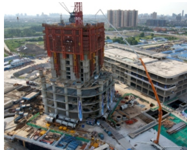
中联重科101米泵车助力“华中第一高楼”建设
