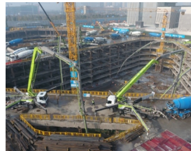
金融城项目建设施工
