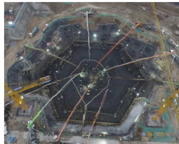
丝路明珠塔项目建设
